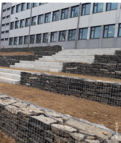
Le bitume retiré pour désimperméabiliser la cour est réemployé pour composer les gradins extérieurs.
