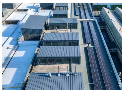
300 m 2 de panneaux photovoltaïques sont installés en toiture des ateliers.
