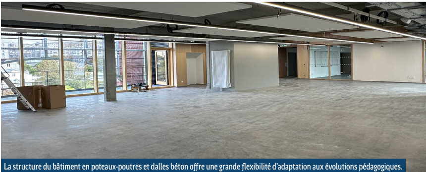
La structure du bâtiment en poteaux-poutres et dalles béton offre une grande flexibilité d'adaptation aux évolutions pédagogiques.
