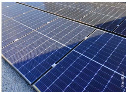
L'énergie produite par les panneaux photovoltaïques en toiture du gymnase sera autoconsommée par l'établissement.
