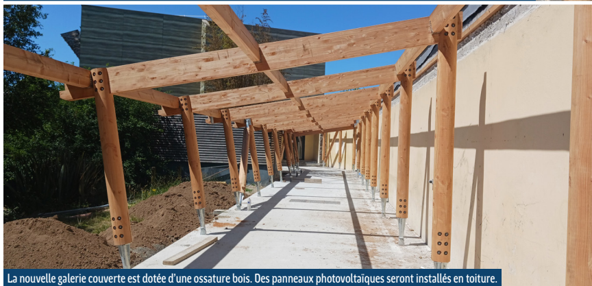
La nouvelle galerie couverte est dotée d'une ossature bois. Des panneaux photovoltaïques seront installés en toiture.
