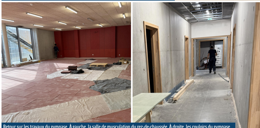
Retour sur les travaux du gymnase. À gauche, la salle de musculation du rez-de-chaussée. À droite, les couloirs du gymnase.
