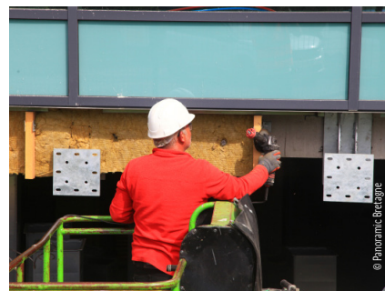
Des brise-soleil ont été installés sur la façade du bâtiment pour éviter les surchauffes lors des périodes estivales.
