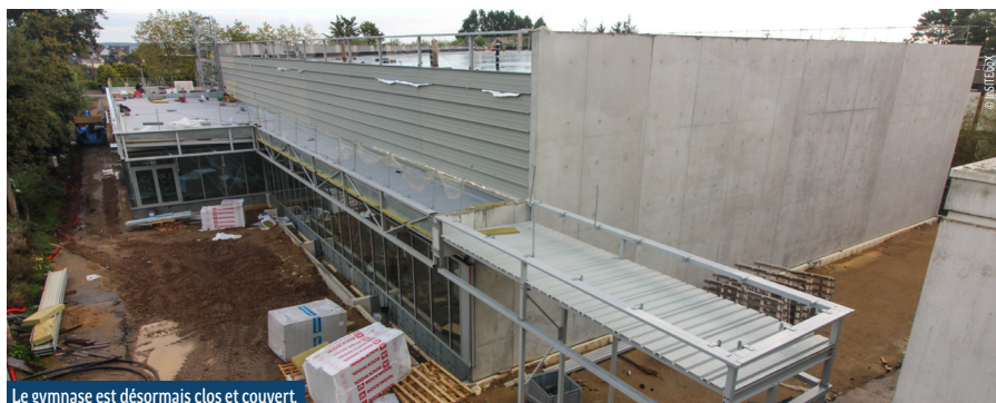
Le gymnase est désormais clos et couvert.
