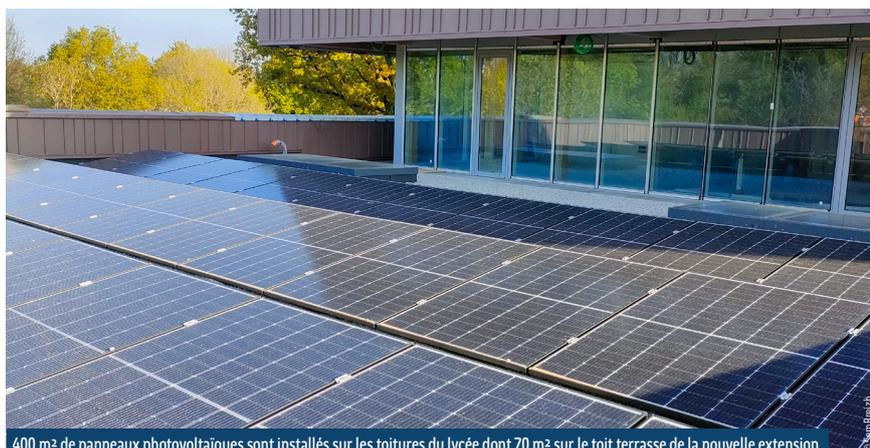
400 m<sup>2</sup> de panneaux photovoltaïques sont installés sur les toitures du lycée dont 70 m<sup>2</sup> sur le toit terrasse de la nouvelle extension.
