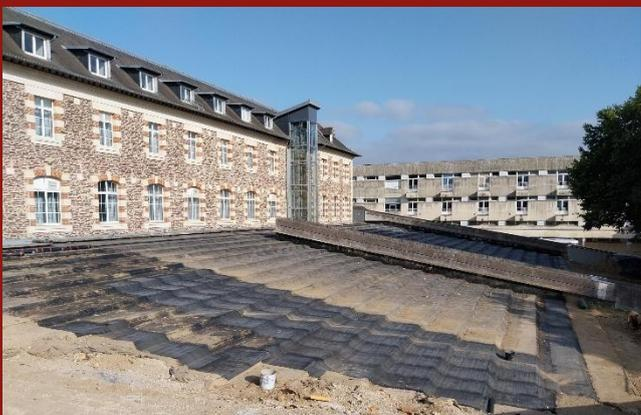
Des travaux d'étanchéité et d'isolation sont réalisés sur les toitures-terrasses des amphithéâtres de l'IEP. © SemBreizh
