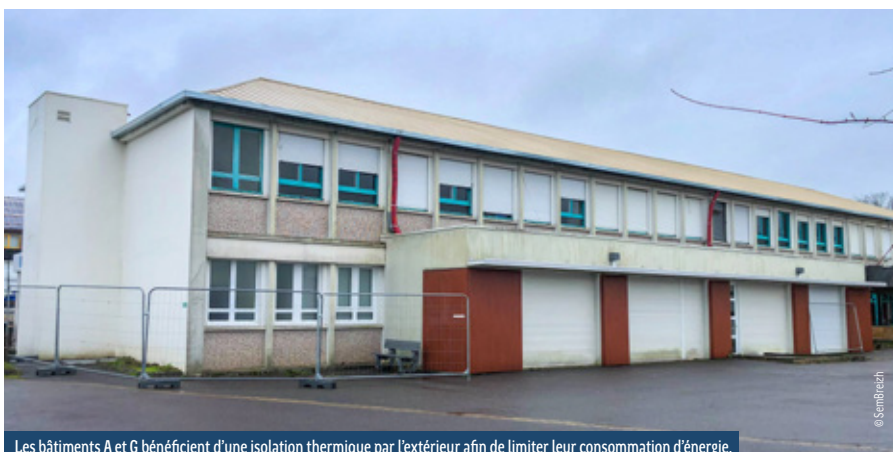
Les bâtiments A et G bénéficient d'une isolation thermique par l'extérieur afin de limiter leur consommation d'énergie.
