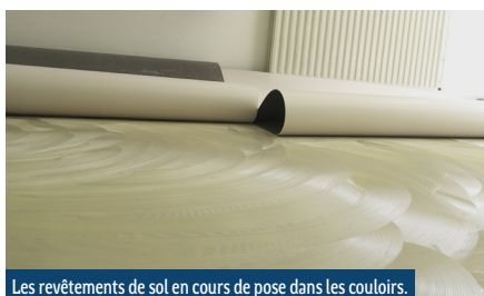
Les revêtements de sol en cours de pose dans les couloirs.
