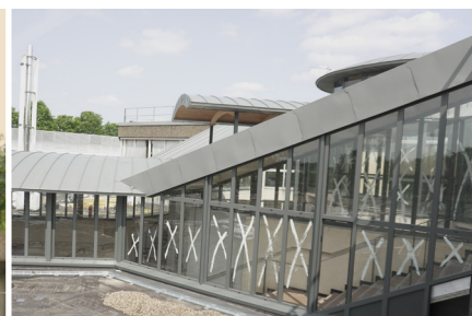
(↓) Lumière naturelle et confort thermique dans les ateliers Mode & Vêtements , salle des professeurs et vie scolaire grâce au remplacement des verrières et à la nouvelle étanchéité des toits terrasses.
