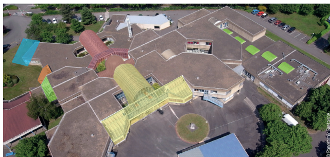
Vue aérienne du bâtiment A avant travaux. En rose, vert et orange les verrières remplacées. En jaune, la seconde phase de travaux qui débute.
