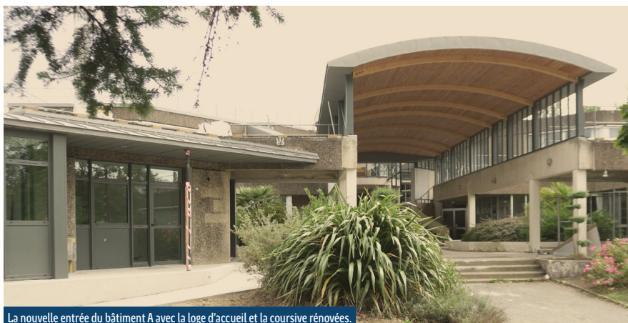
La nouvelle entrée du bâtiment A avec la loge d'accueil et la coursive rénovées.
