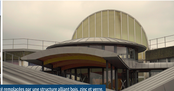
Les verrières du dome et des coursives ont été remplacées par une structure alliant bois, zinc et verre.
