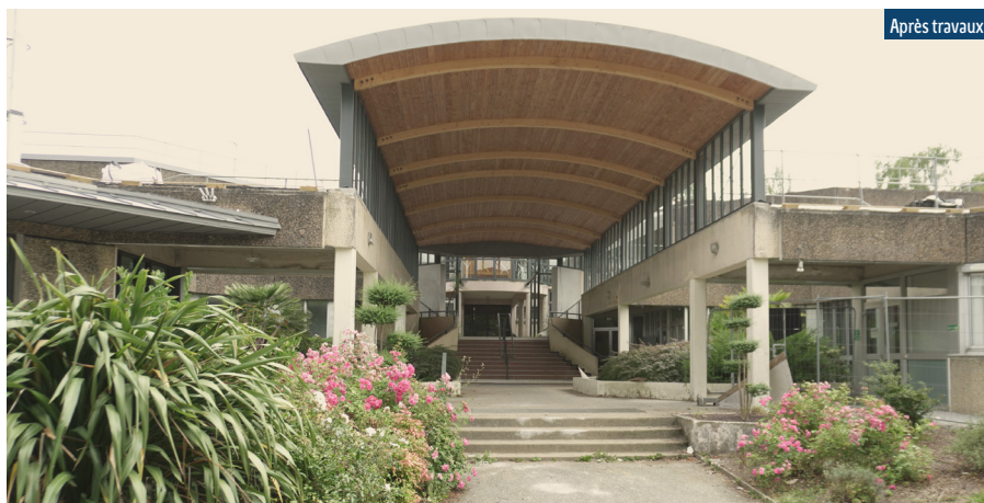
A l'entrée du bâtiment A, une nouvelle structure alliant bois, zinc et verre est venue remplacer l'ancienne verrière (photo de droite) © SemBreizh
