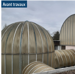
Les verrières du dome et des coursives ont été remplacées par une structure alliant bois, zinc et verre.
