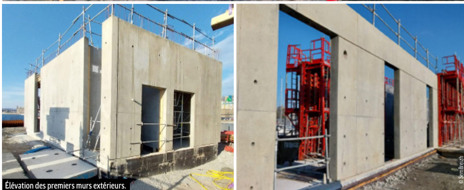
Élévation des premiers murs extérieurs.
