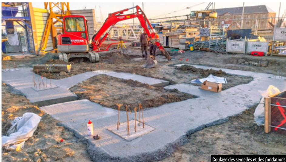
Coulage des semelles et des fondations.
