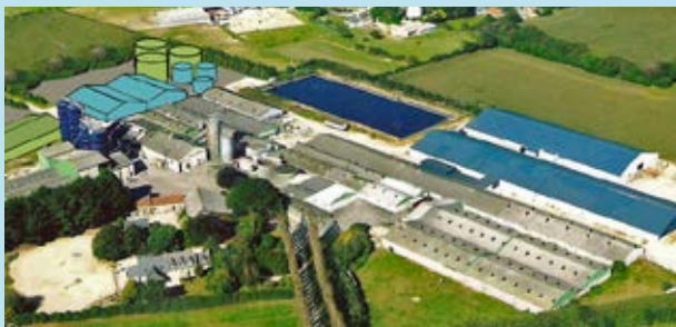
Projet Biomasse énergie du Léon à Plouvorn, mise en service prévue en 2016.
